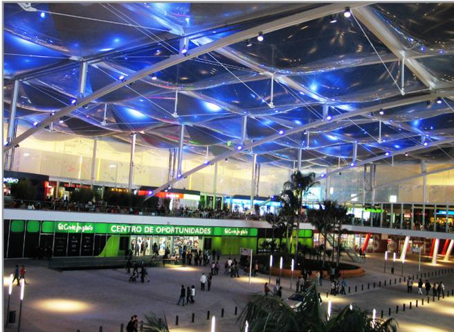
**Visualisierung des „Dolce Vita Shopping Complex“ in Lissabon, Portugal mit ETFE Membrandachelementen, jedes Dachelement kann dabei wahlweise mit Solarzellen oder elektrochromen Folien ausgestattet werden**
