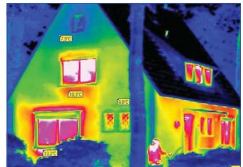
Besonders hoher Wärmeverlust über die Fenster – sichtbar durch eine thermografische Aufnahme
